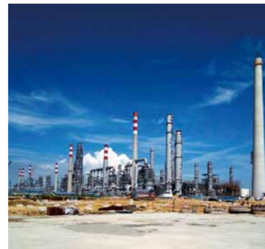
惠州炼化分公司是中国海洋石油总公司独资兴建的第一个大型炼厂，也是世界上第一座集中加工高含酸重质原油的炼厂，位于广东省惠州市大亚湾经济技术开发区，毗邻深圳和香港，占地面积 2.68 平方公里，一期总投资 216 亿元，原油加工规模为 1200 万吨 / 年，包括常减压蒸馏、加氢裂化、延迟焦化、连续重整等 16 套主要生产装置，配套原油和成品油码头、储罐及公用工程设施等。主要生产汽油、航煤、柴油、苯、液化气、丙烯、乙烯裂解料、硫磺、石油焦等 15 大类 1150 多万吨石化产品。炼油项目于 2004 年 8 月获得国家发改委批准，2006 年 11 月破土动工，按照“差异化、清洁化、信息化、高价值”的建设标准，2009 年 3 月全部工程实现安全、优质机械竣工，同年 4 月一次投产成功，创造了国内单系列规模最大、开工时间最短、行业内大型炼厂一次投料试车成功的业界记录，2011 年荣膺 IPMA 国际卓越项目管理金奖、中国项目管理成就奖、国家技能人才培养突出贡献奖等国内外大奖。
