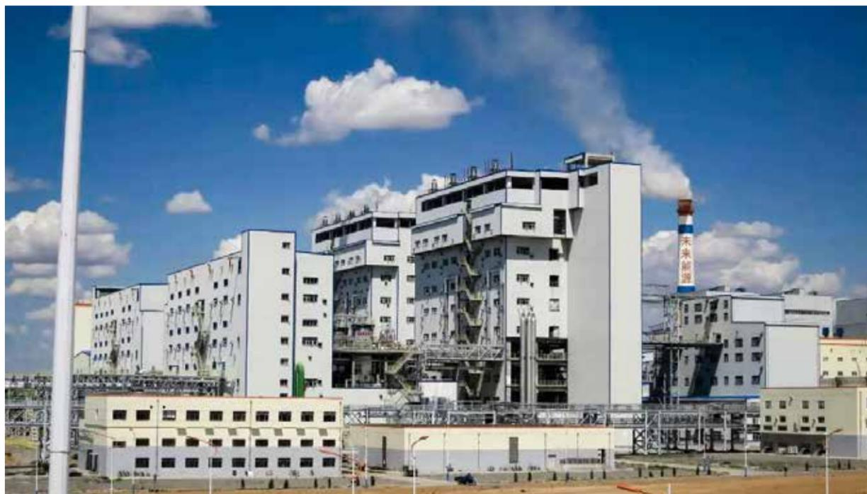
陕西未来能源 100 万吨 / 年低温费托合成煤间接液化示范项目是由山东兖矿集团投资建设，山东省正大建设监理有限公司承担施工阶段监理，2012 年开工，2015 年顺利投产。主要装置包括 4 套 8.5 万标准立方米 / 小时空分装置，8 台（6 开 2 备）日处理煤量 2000 吨的多喷嘴对置式水煤浆加压气化炉，3 套一氧化碳变换装置，3 套处理气量为 27 万标准立方米 / 小时低温甲醇洗装置，2 套硫回收装置，1 套费托合成装置，1 套费托合成油品加工装置，1 套尾气制氢装置，3 台 480 吨蒸汽 / 小时高压煤粉锅炉，3000 吨 / 年费托合成催化剂生产装置等。共有大型设备 500 余台（套），按设备台套数计算，项目装备自主化率达到 92% 以上。
