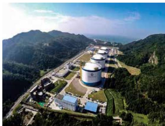
中海油深圳 LNG 项目位于大鹏新区官湖社区，占地面积 27 公顷，建设规模为四个 16 万方大容量储罐、一座 8 万 -26.6 万方 LNG 船专用泊位及配套气化外输设施，设计处理规模为 400 万吨 / 年。深圳 LNG 项目是中海油在广东大鹏 LNG 项目获得巨大成功后，在深圳兴建的第二个 LNG 项目，项目总投资约 80 亿元，中海石油气电集团有限责任公司占该项目 70% 股权，深圳能源集团持有 30% 的股权，项目于 2017 年完成验收，2018 年投产。深圳 LNG 正式投产运营，不仅为珠三角地区增加优质高效的清洁能源供应，而且在管线连通后，为冬季我国北方天然气保供增加 1700 万方 / 天的供应能力。
